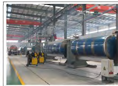
化工车间一角
