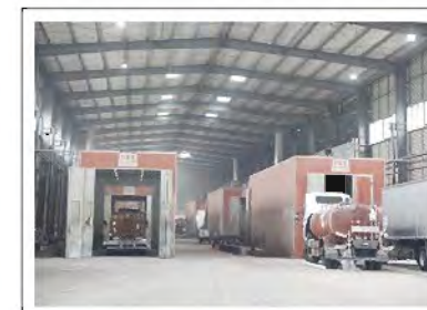
喷砂室、喷漆房、烤漆房
