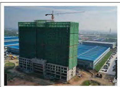
在建新办公楼
